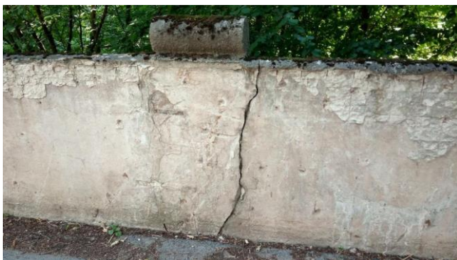
-Trhlina v zábradelní zídce vlevo
