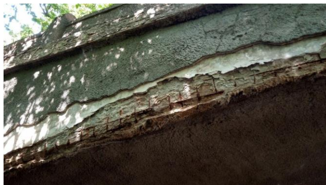
-Zátékání, degradace NK
