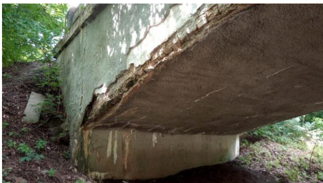
-Opěra OP2, odpadá omítka z klenby, degradace betonu a výztuže
